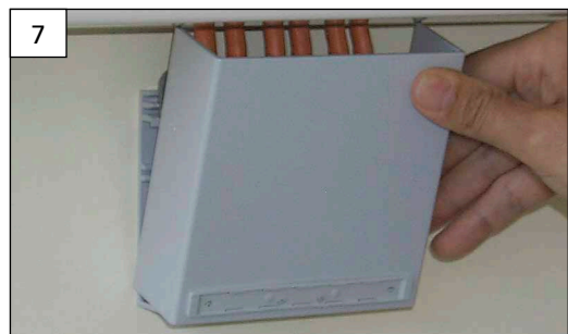
Öffnen des Aufputzverteilers / Opening the surface mount / Ouvrir le boîtier de l'appareil
