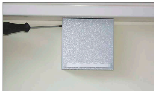
Öffnen des Aufputzverteilers / Opening the surface mount / Ouvrir le boîtier de l'appareil
